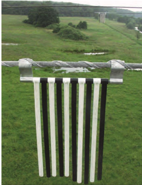
Слика 9. Уредот за обележување RIBE е достапен како серија од црно-бели крути пластични парчиња кои се нишаат.
